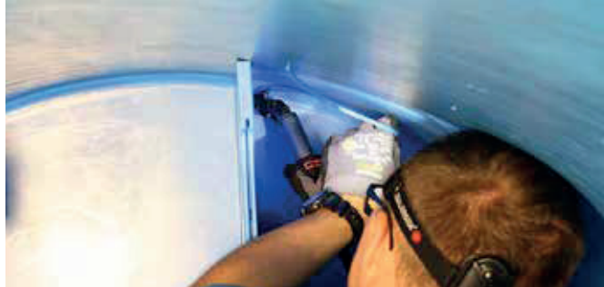
Con el WELDING PEN R y los adaptadores de ángulo se pueden soldar incluso las zonas estrechas.
