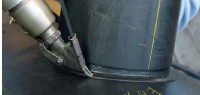
Soldadura por tracción con boquilla combinada.
