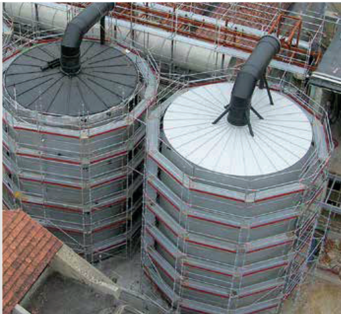
Sistema de purificación de aire, España. Material: HD-PE
