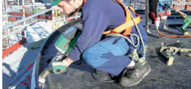
WELDPLAST S4 en uso exterior en España.
