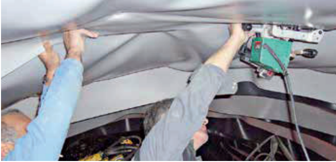
Trabajando con la COMET en un túnel ...
