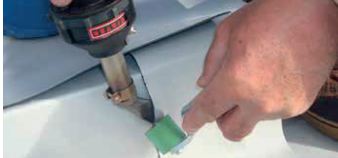
HOT JET S con tobera angulada en soldadura de una unión en T en un tejido.
