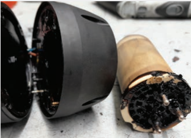
Daños causados por gases externos
