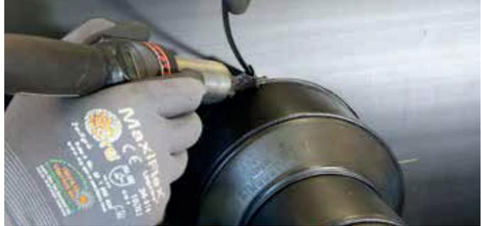
Soldadura de arrastre con el ergonómico WELDING PEN.
