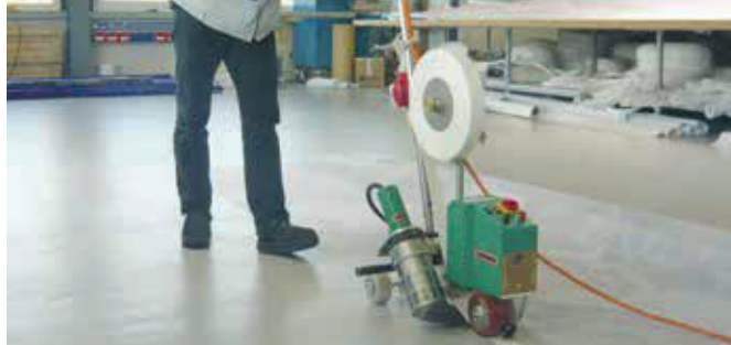
Soldadura de bandas a máxima velocidad.
